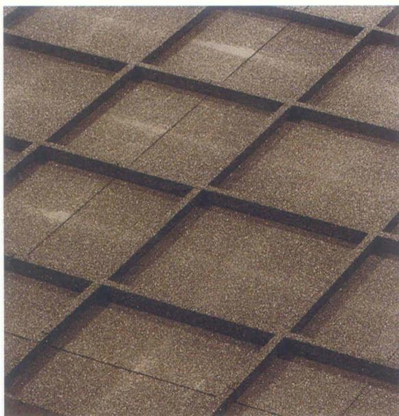
Die einzelnen Basisplatten werden fluchtgerecht aneinander gelegt, so dass ein fugenübergreifendes Raster entsteht. Die Verlegung erfolgt lose schwimmend auf dem alten, ebenflächig vorbereiteten Untergrund.
