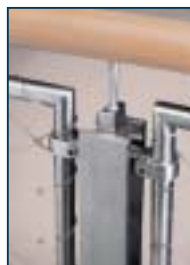
Befestigung zweier gerader Rahmen mittig an Pfosten
