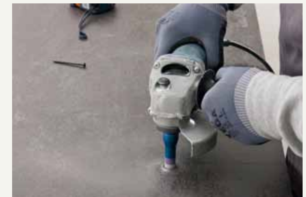
fig.25 /Per ottenere fori tra i 4 ed i 12 mm usare punte o foretti da trapano. Per ottenere diametri maggiori utilizzare frese a tazza diamantate da applicare alla smerigliatrice, che è possibile usare sia a umido che a secco. Si suggerisce comunque di effettuare la foratura a umido: per far ciò è sufficiente irrorare con acqua l'area interessata o utilizzare utensili predisposti. Si raccomanda di non usare il percussore manuale. / To obtain holes of between 4 and 12 mm, use drill bits. To obtain larger diameters, use diamond hollow cutters applied to the grinding machine, which can be used either wet or dry. We nonetheless suggest you perform wet drilling: to do this, simply sprinkle the area concerned with water or use purpose-designed tools. We strongly advise against the use of a manual hammer.
