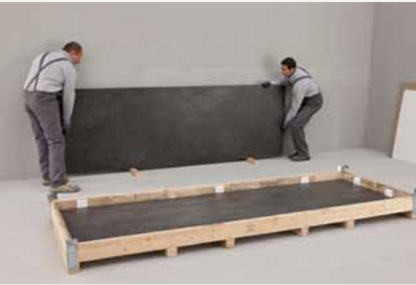
fig.7 / Appoggiare delicatamente la lastra sul lato lungo, mantenendola leggermente inclinata e facendo attenzione a sistamarla su materiale morbido o listelli di legno opportunamente distanziati. /Lay the slab gently on the long side, keeping it slightly sloped and caring to arrange it on soft material or suitably spaced wooden strips.
