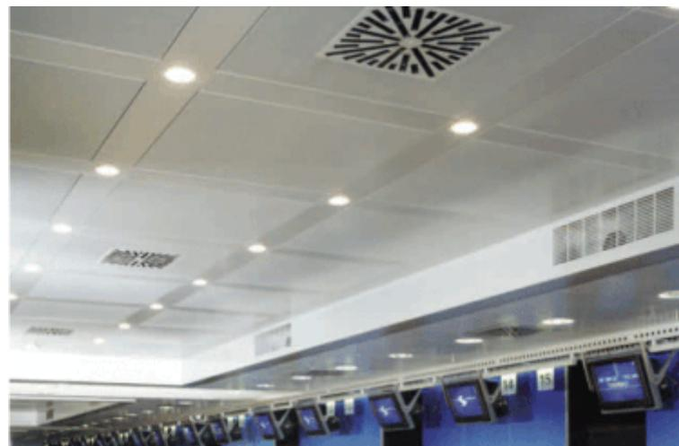
Il sistema CROSS SADI ha trovato larghissimo impiego nella realizzazione di controsoffittature delle grandi stazioni aeroportuali. Il successo del sistema è stato certificato dagli stessi progettisti che hanno potuto coniugare con estrema facilità le necessità impiantistiche con le loro esigenze di estetica, di acustica, di facile manutenzione. I controsoffitti modulari CROSS, particolarmente adatti per ampie superfici, rendono confortevoli gli ambienti di lavoro.
