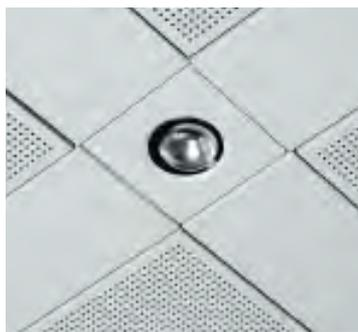
Questo faretto è stato inserito nella struttura portante del sistema CROSS in un foro imbutito senza ghiera perimetrale. Da ciò si può dedurre che nel sistema CROSS non è vincolante la sospensione nella crociera della struttura, ma può essere posizionata lungo il travetto nella posizione più favorevole.
