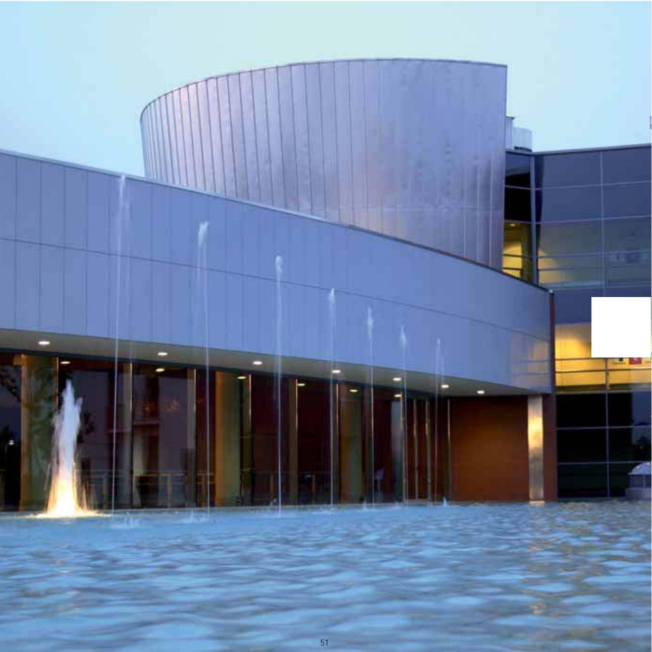
ALUCOBOND® è un pannello composito costituito da due lamiere in lega di alluminio e da un nucleo di polietilene nero accoppiati con un procedimento di fabbricazione in continuo che ne consente il taglio a misura .
