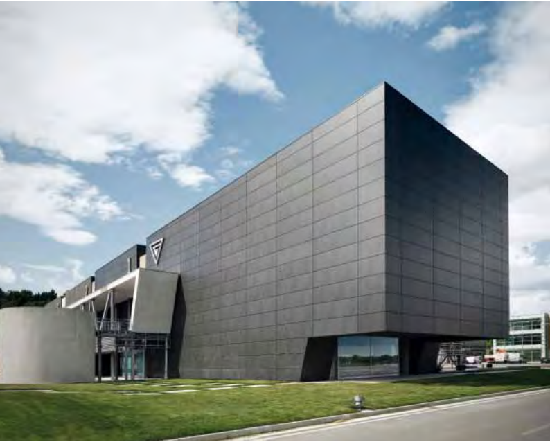
/Tolentino Year:2010 Multiplex Cinema Designer: Ubaldo Severini Architetto Tolentino/Italy Laminam Esterna Blend Nero ←
