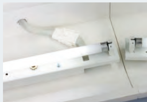
Einspeisung der T16 Einlegeleuchten Power feed of the T16 luminaires Alimentation des luminaires encastrables T16
